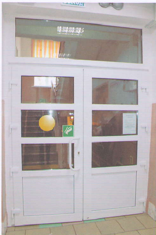
Фото № 12 Вход на лестницу с 1-го этажа.
