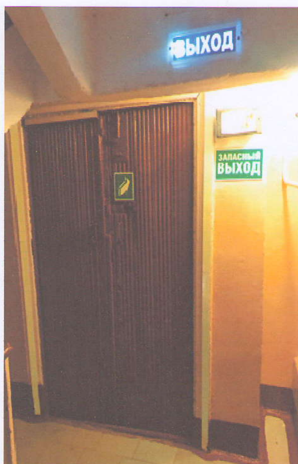
Фото №13 Эвакуационный выход.
